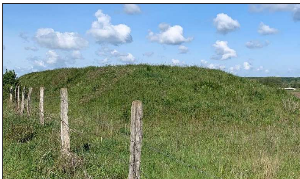
Site clôturé avec merlons
